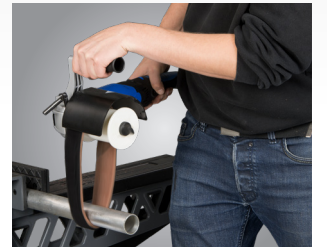
► Satinieren von Rundstahl mit Klettvlies auch bei z.B. bereits montierten Edelstahlgeländern
